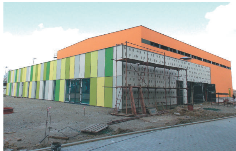
W budowanej właśnie hali będziemy grać i ćwiczyć po przyszłorocznych wakacjach
