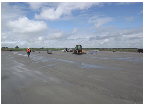
Budowa placu dojrzewania kompostu - maj 2013
