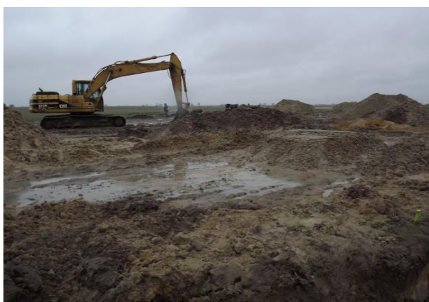
Budowa placu dojrzewania kompostu - styczeń 2013
